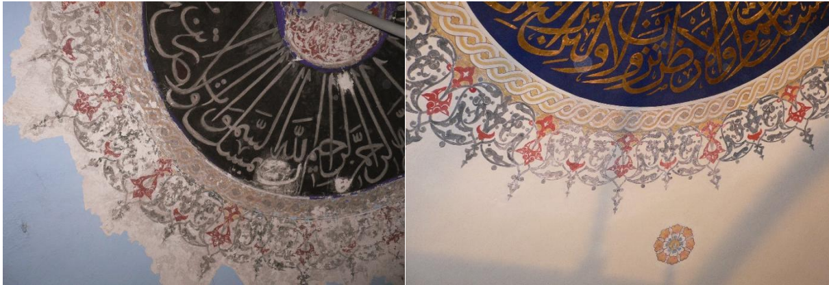
Resim 2. Sıvaüstü Kalemişi Özgün Örnek ve Yenilemesi
